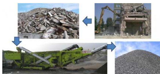
Dây chuyền xử lý chất thải xây dựng rắn thành vật liệu thứ cấp
