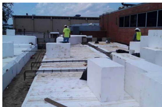
Các block EPS trên công trường thi công
